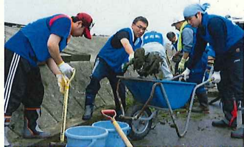
重い泥を掻き出して。
